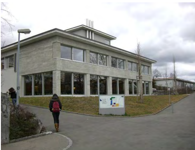
Abbildung 4.2 KZO: Mensatrakt mit den Unterrichtszimmern im Obergeschoss; im Hintergrund der Trakt K (links neben der Strassenlampe ist der Luftansaug im Obergeschoss erkennbar)
