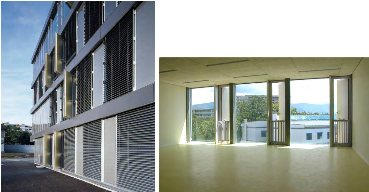
Abbildung 7.2 Ein Objekt mit ähnlichen Lüftungsflügeln, hingegen nach Aussen öffnend wurde kürzlich in Genf fertig gestellt (Cycle d'orientation Cayla, photo: Susanna Fritscher)
